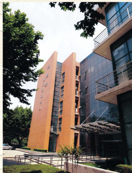
在员工灶原址新建的健翔楼 (2008.5)
